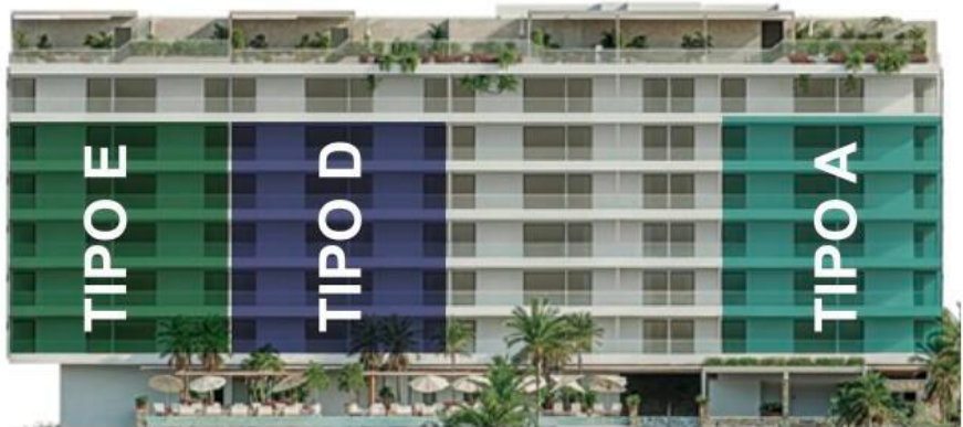
UBICACIÓN EN FACHADA
